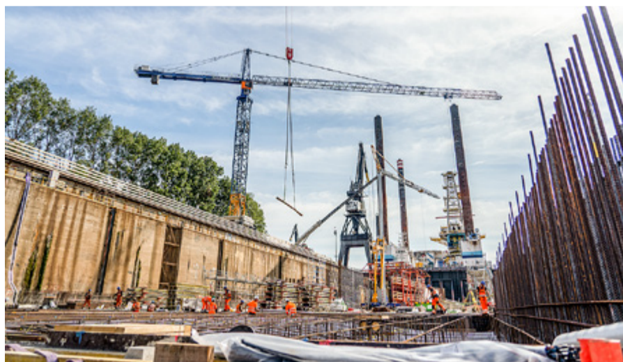
Betonstaalvluchtwerk in het dok van Damen Verolme voor de nieuwe tunneldelen.
