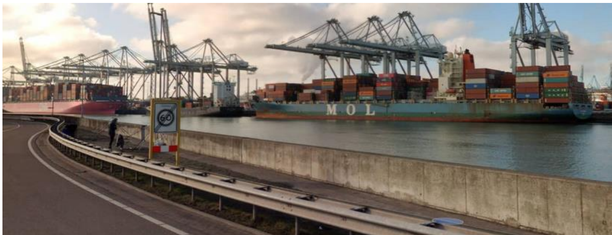
Figuur 3-4. Huidige muur langs de zuidzijde van de Amazonehaven
