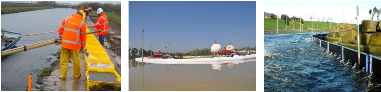
Figuur 3-8. Voorbeelden van noodkeringen: Box Barrier (links), systeem gevuld met lucht (midden) en vrijstaand keermiddel (rechts).
