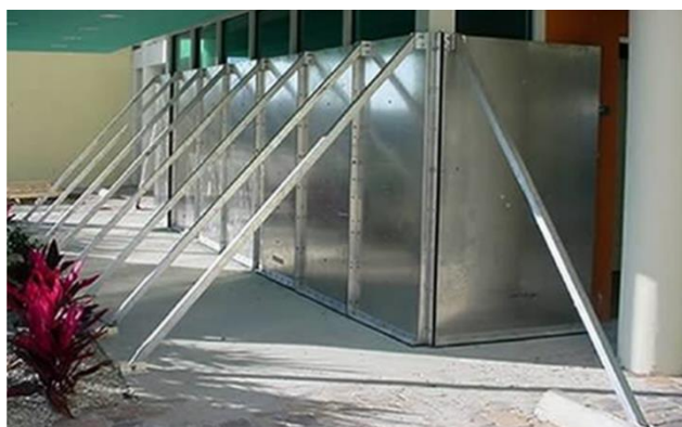
Foto. Voorbeelden van 'Dry proofing' met panelen om een gebouw waterdicht te maken (links) en waterdichte deuren die gesloten kunnen worden (rechts).
