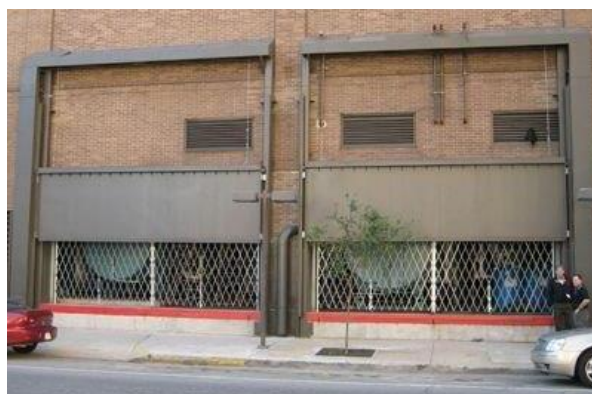
Foto. Voorbeelden van 'Dry proofing' met panelen om een gebouw waterdicht te maken (links) en waterdichte deuren die gesloten kunnen worden (rechts).
