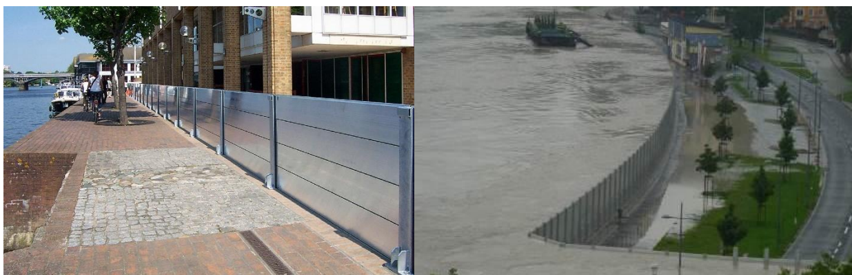
Figuur 3-5. Voorbeeld van de toepassing van demontabele keringen; Links nadat ze zijn geïnstalleerd voorafgaand aan een hoogwater; Rechts ten tijde van hoogwater.
