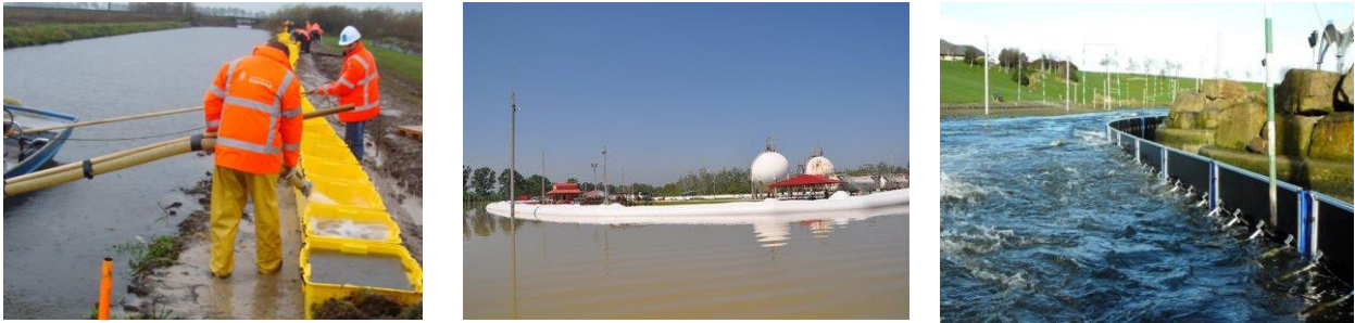
Figuur 20. Voorbeelden van noodkeringen: Box Barrier (links), systeem gevuld met lucht (midden) en vrijstaand keermiddel (rechts).
