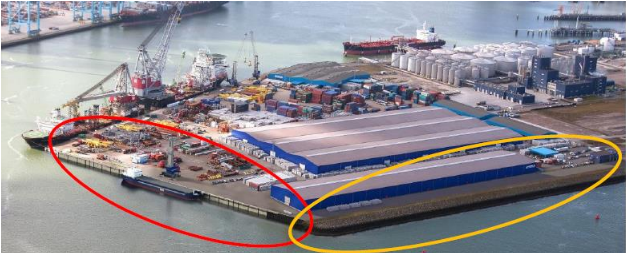
Figuur 13. Kade waar schepen kunnen aanmeren (links in rode ellips), glooiing met steenbekleding (rechts in gele ellips). Bron: Havenbedrijf Rotterdam.
